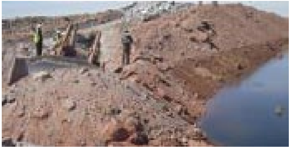
UNE VUE DES BASSINS DE STOCKAGE DONT LES DIGUES ONT CÉDÉ
